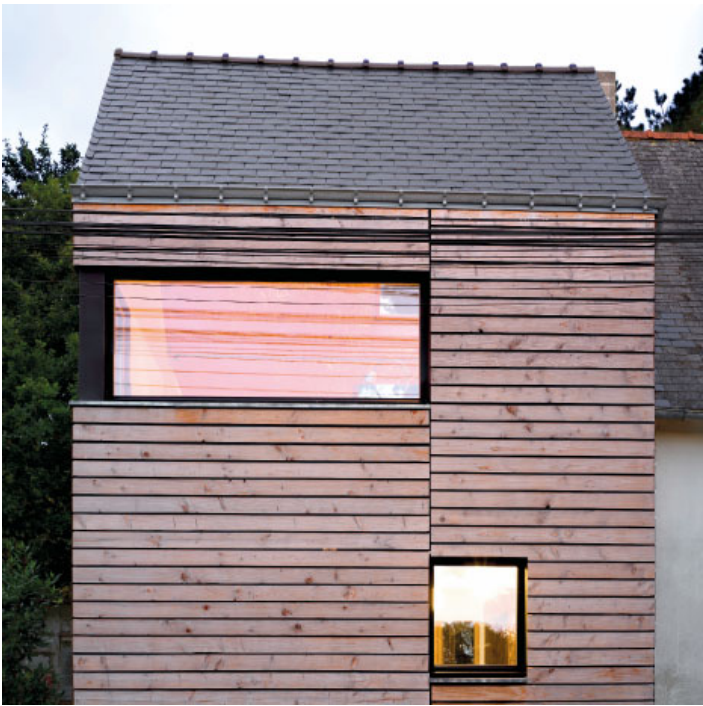
au-dessus façade sur rue
